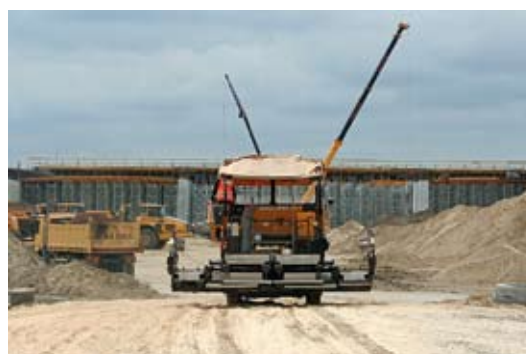
Roboty związane z budową drogi S5 na węzle Białe Błota
